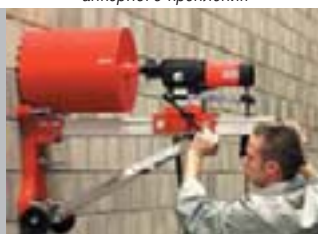
Использование набора анкерного крепления
